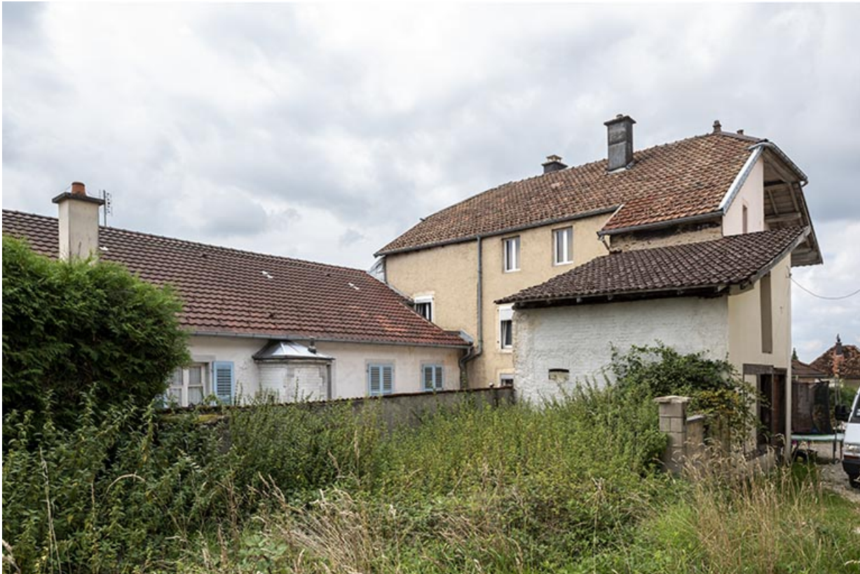
Bâtiment au 2 rue du Chêne : façade postérieure.
