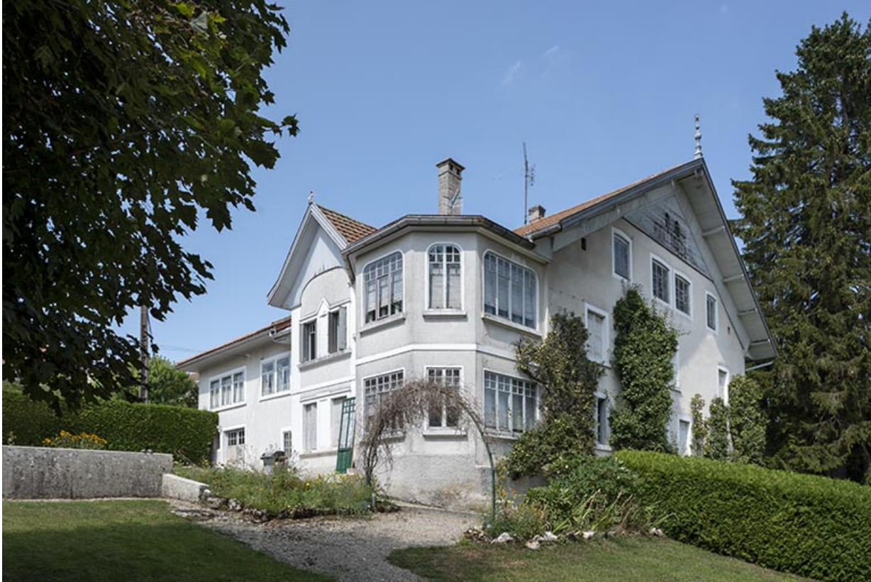
Ancienne ferme : façades antérieure et latérale droite.
