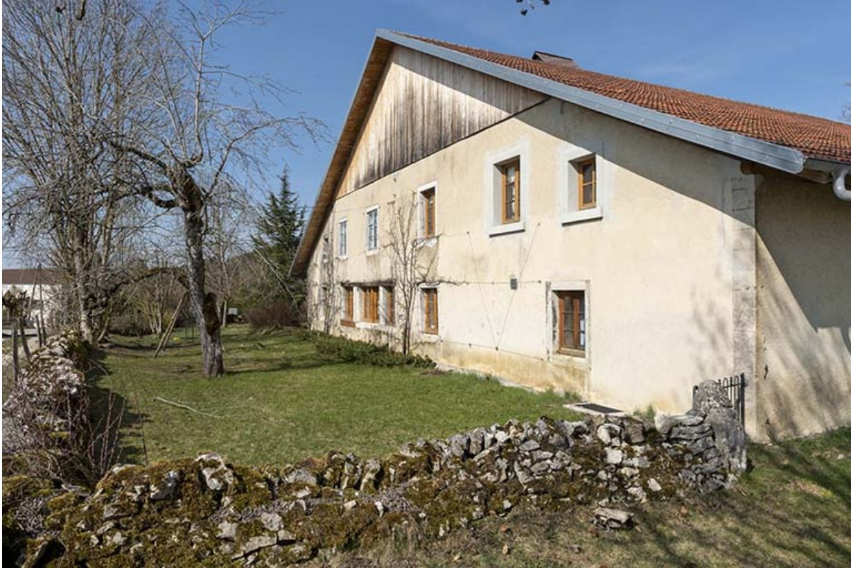
Façade sud, vue en enfilade.
