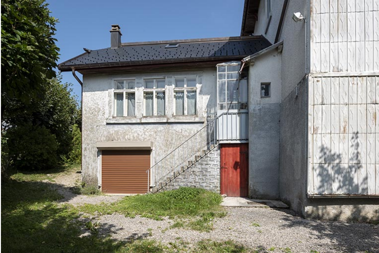
Façade postérieure de l'atelier.
