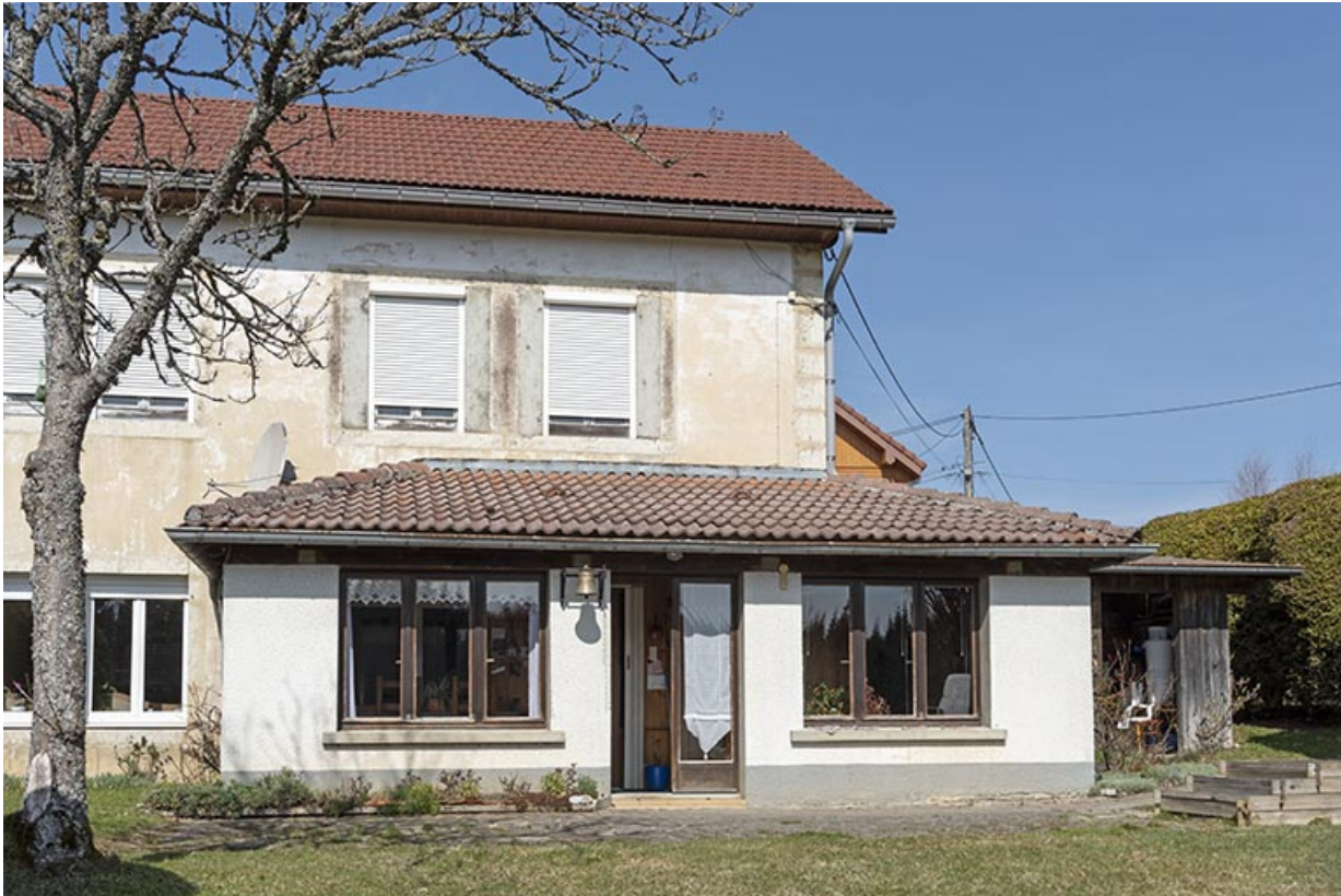
Façade postérieure : extension orientale.
