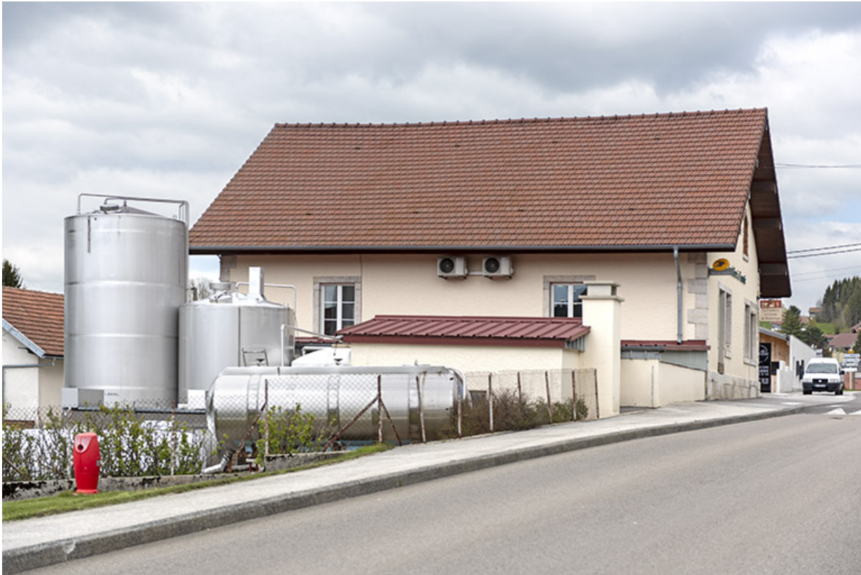
Façade latérale gauche.
