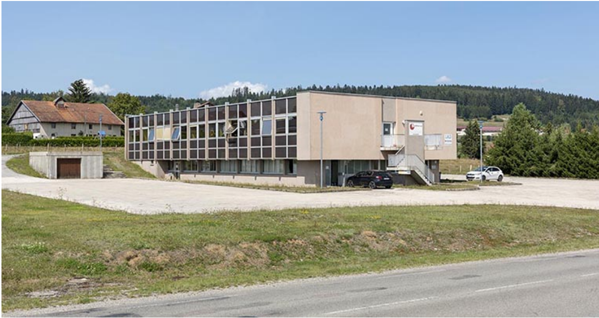
Façades antérieure et latérale droite.
