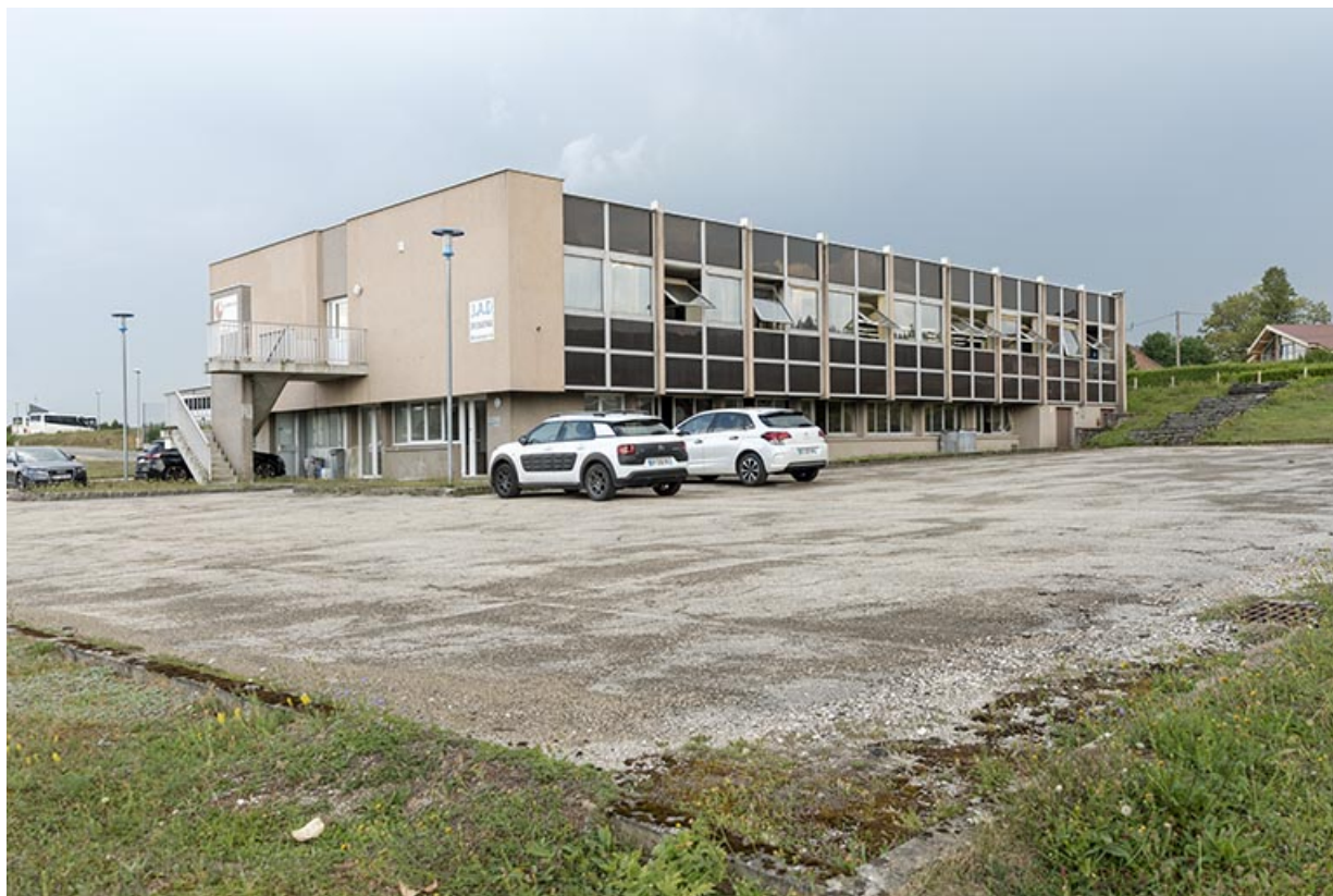
Façades postérieure et latérale droite.
