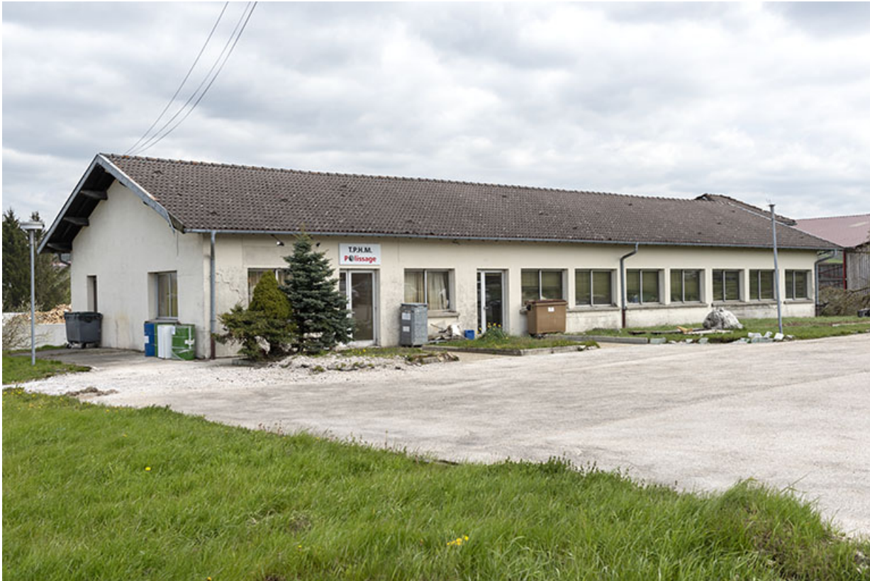
Façades antérieure et latérale gauche.
