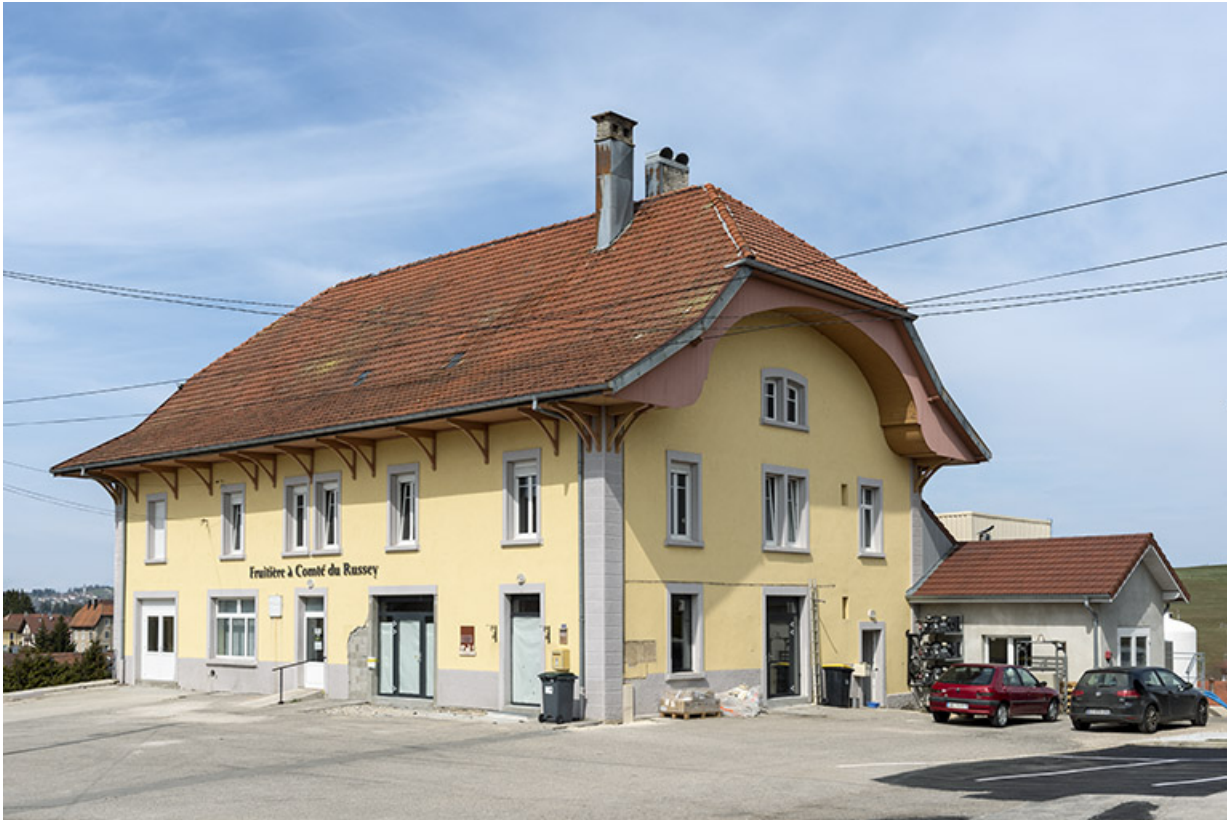
Façades antérieure et latérale droite.
