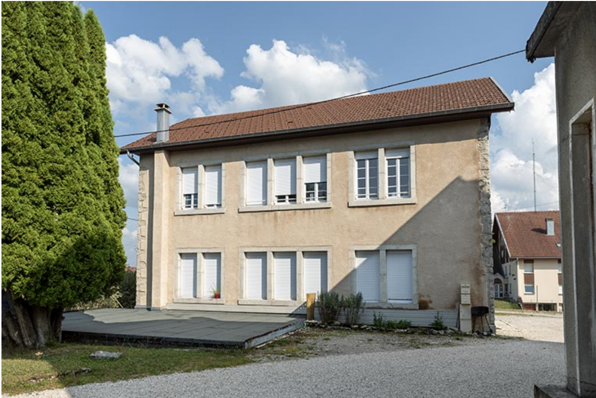
Atelier de fabrication : façade ouest.
