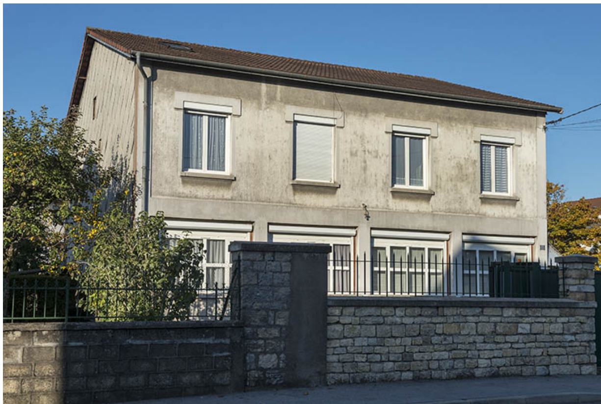
Façade est de l'atelier.
