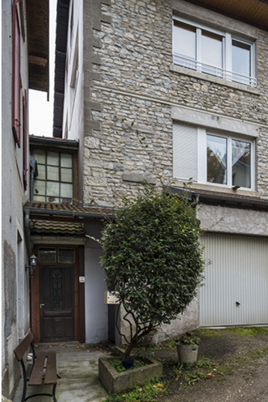
Extrémité sud de l'atelier de fabrication.
