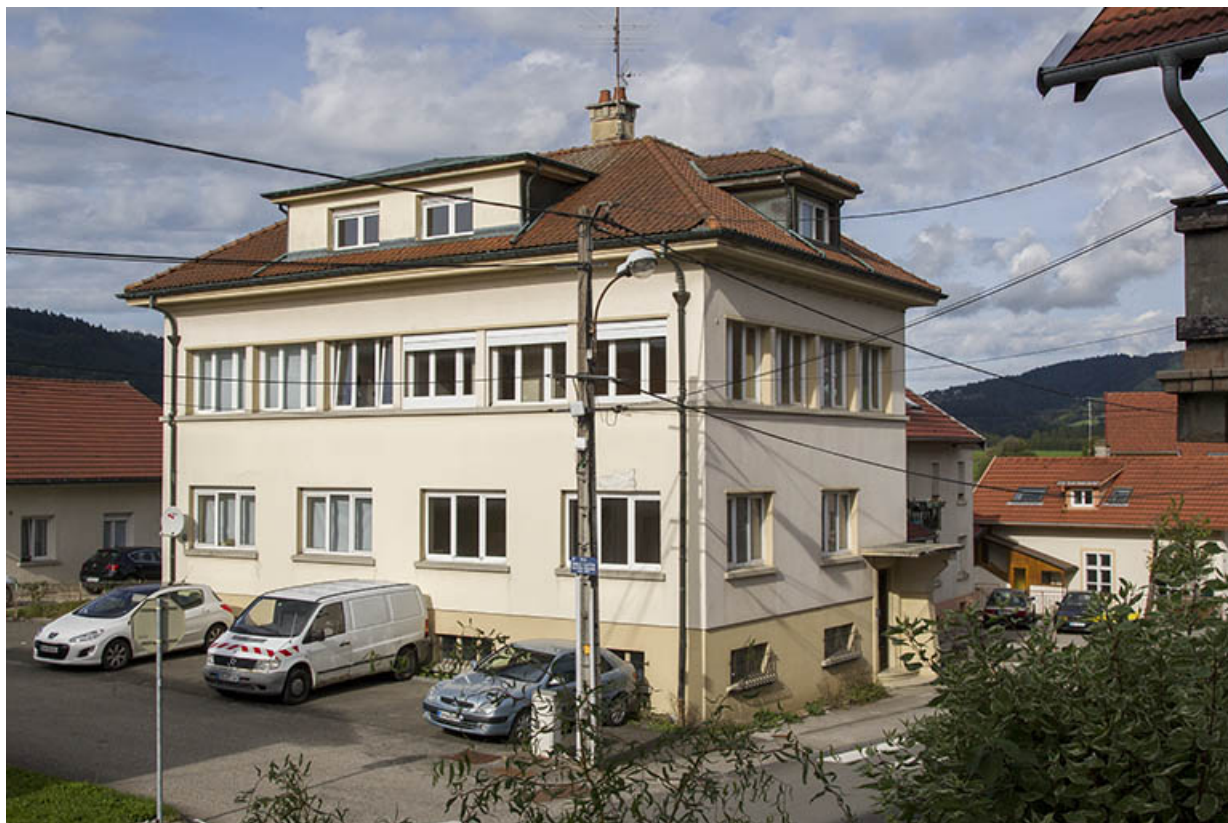
Usine : façades antérieure et latérale gauche.
