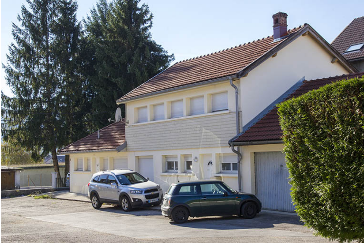
Bâtiment sur cour, de trois quarts droite.
