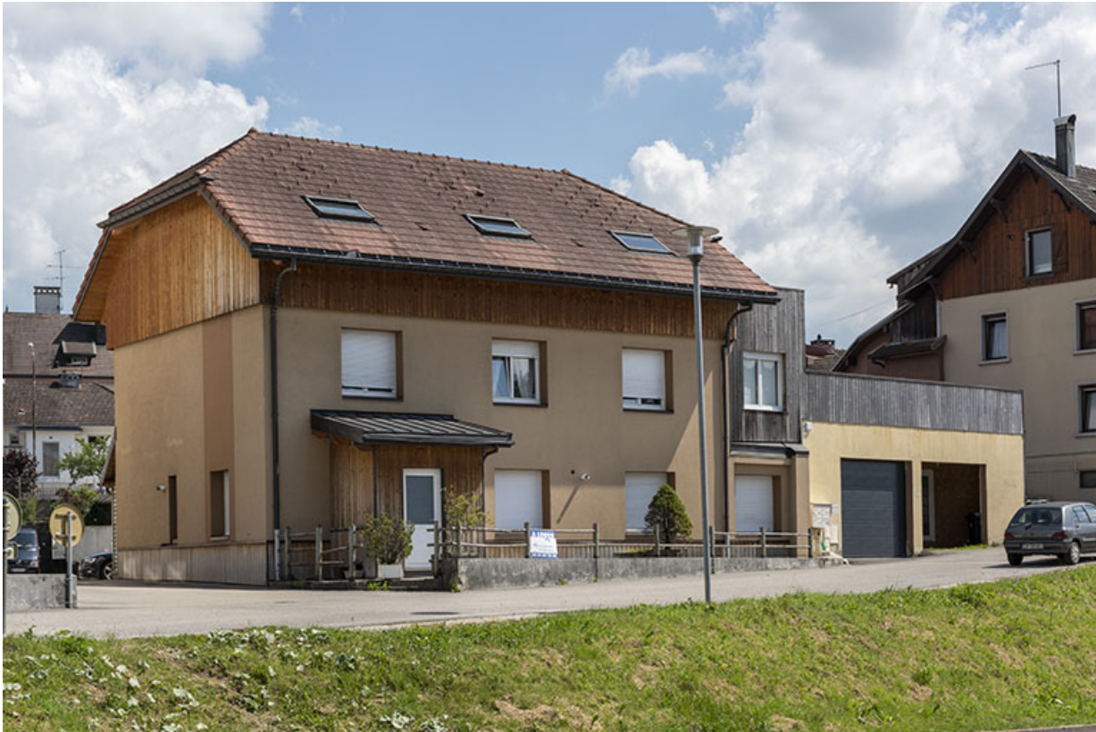
Ancien pavillon (à droite).
