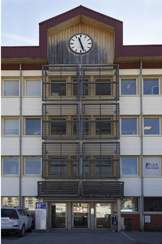
Usine : travées centrales de la façade antérieure.
