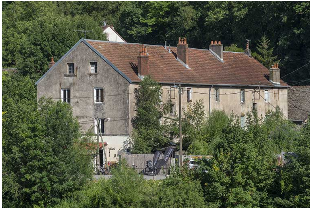
Logement ouvrier. Vue depuis le nord-ouest.
