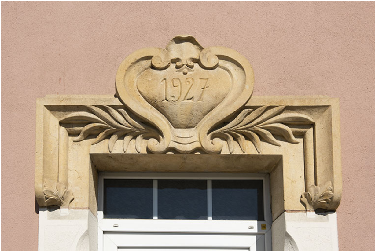
Façade antérieure : linteau daté 1927.
