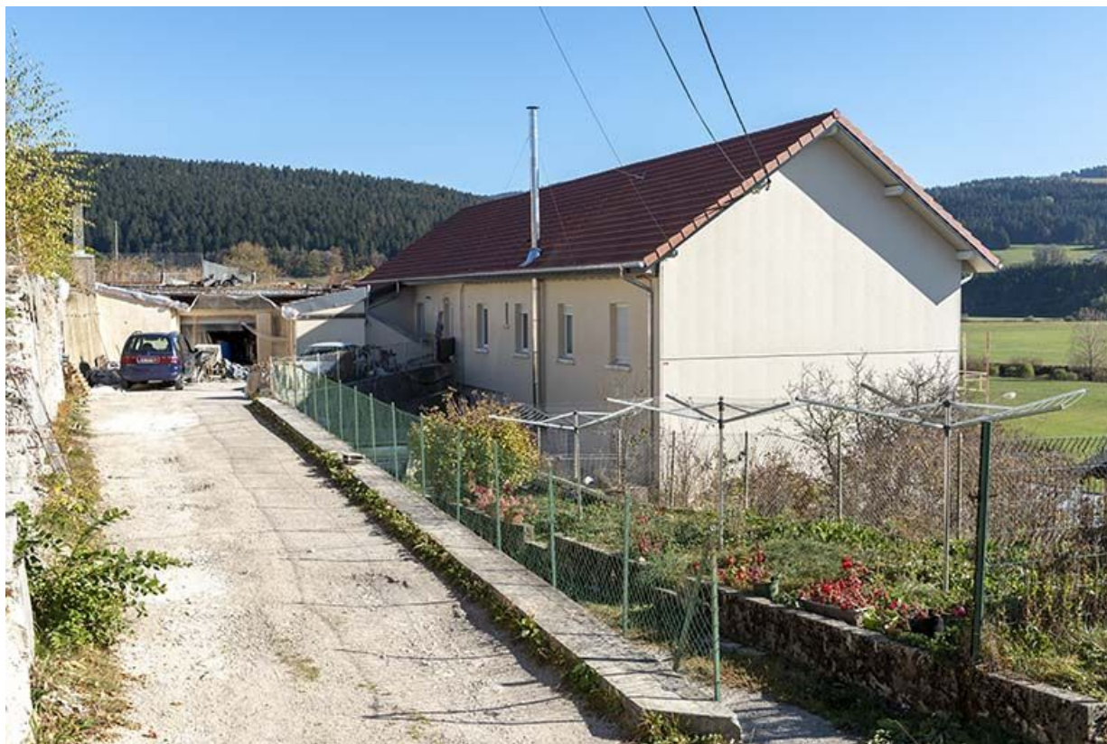
Façades sur la rue du Mondey.
