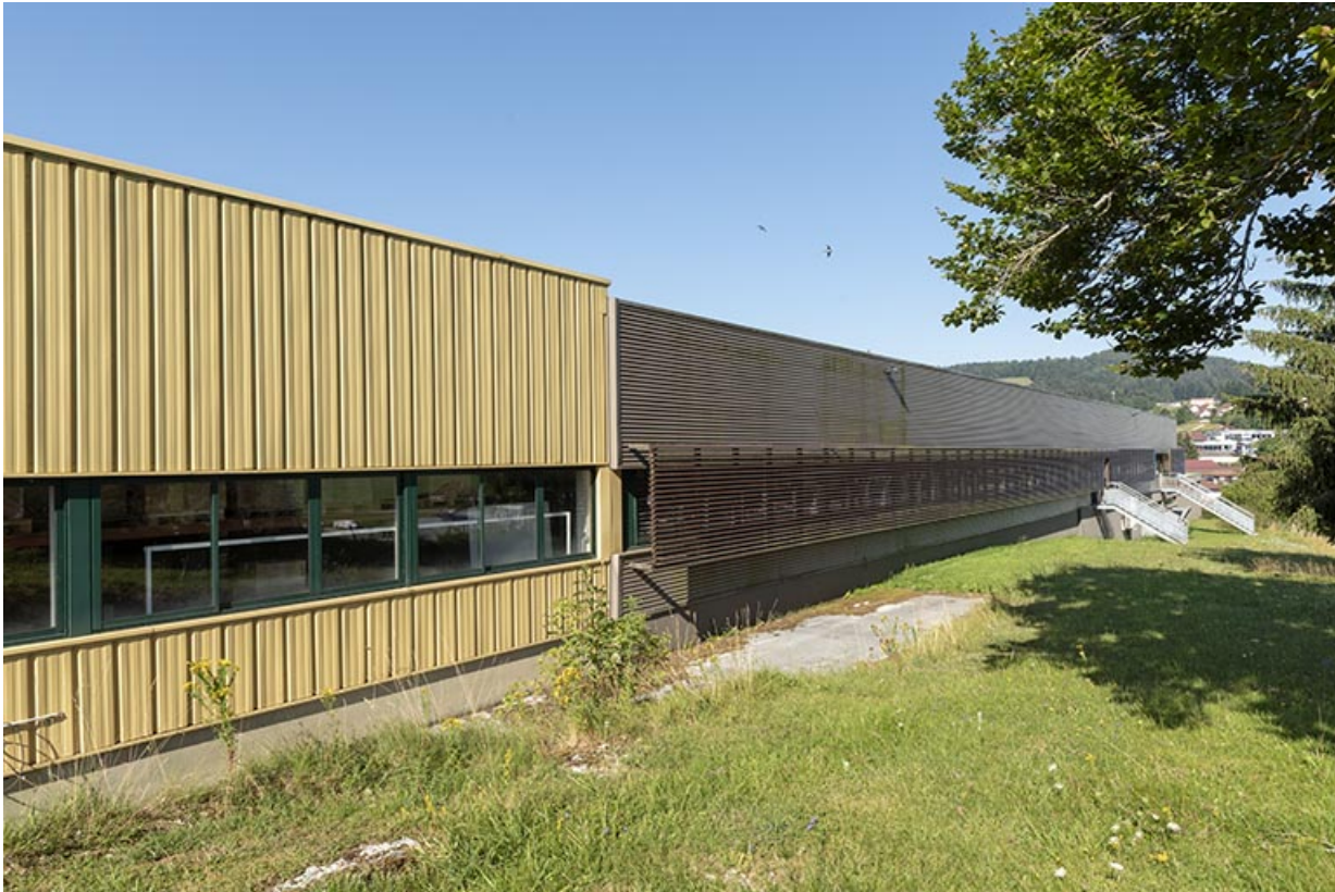
Façade postérieure, vue en enfilade.
