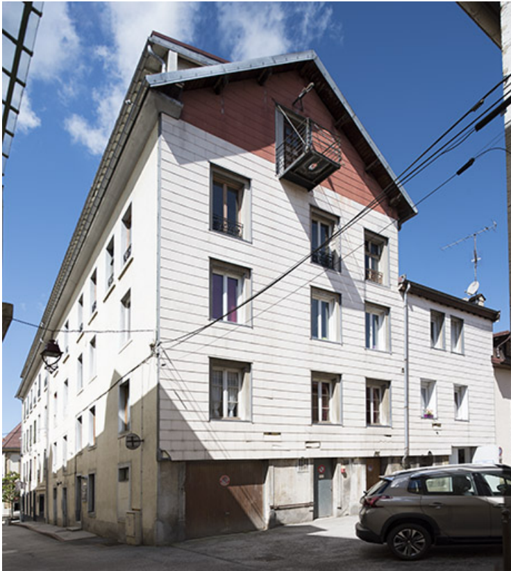
Façades postérieure et latérale droite.
