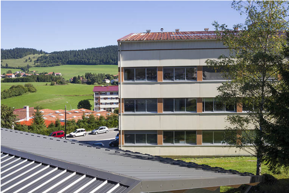
Corps nord : façade postérieure.
