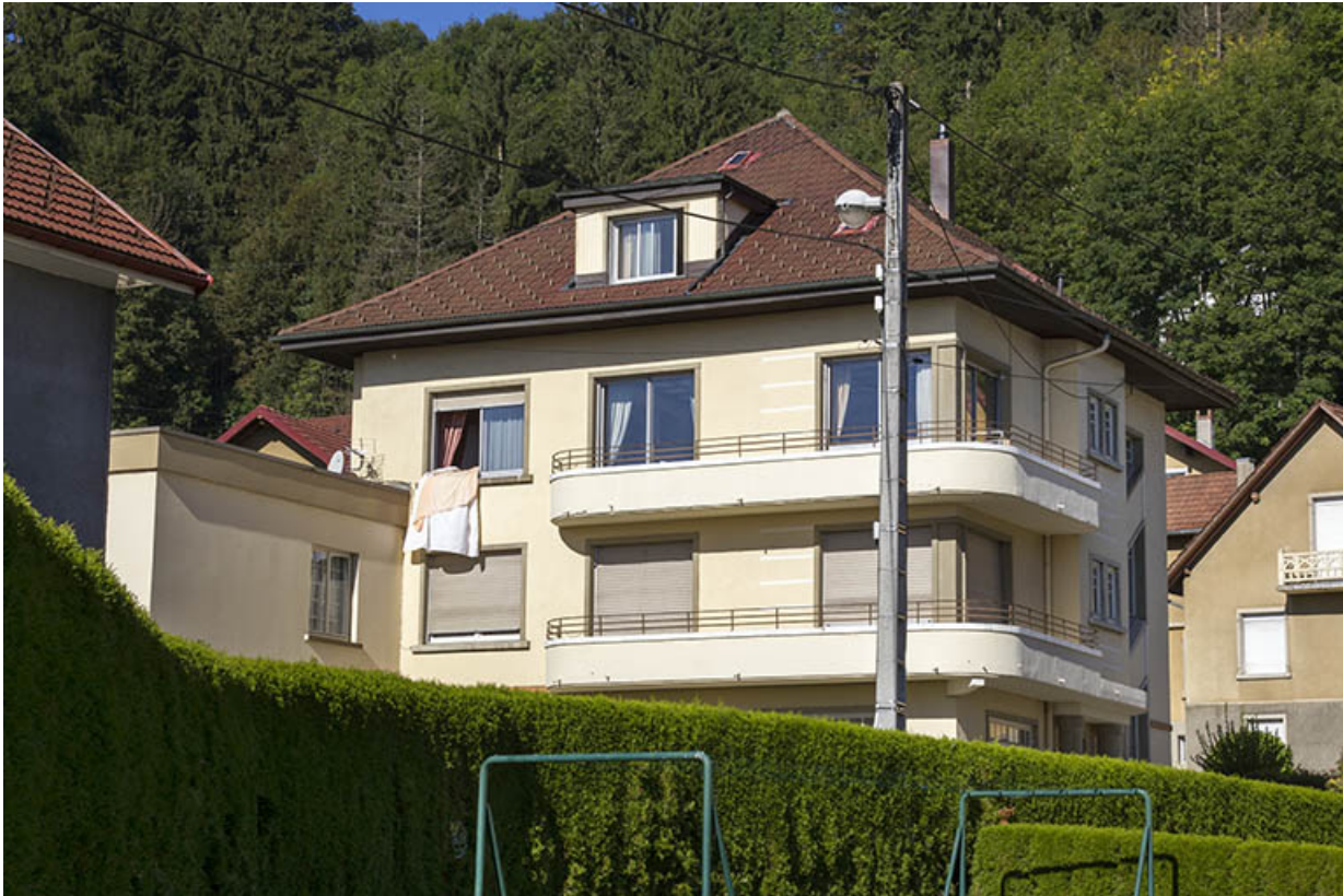
Façades postérieure et latérale gauche.
