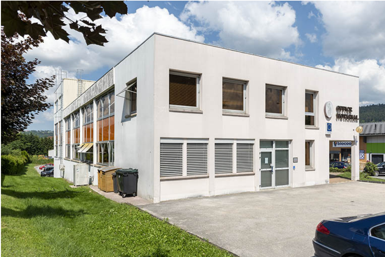
Façade sud, de trois quarts gauche.
