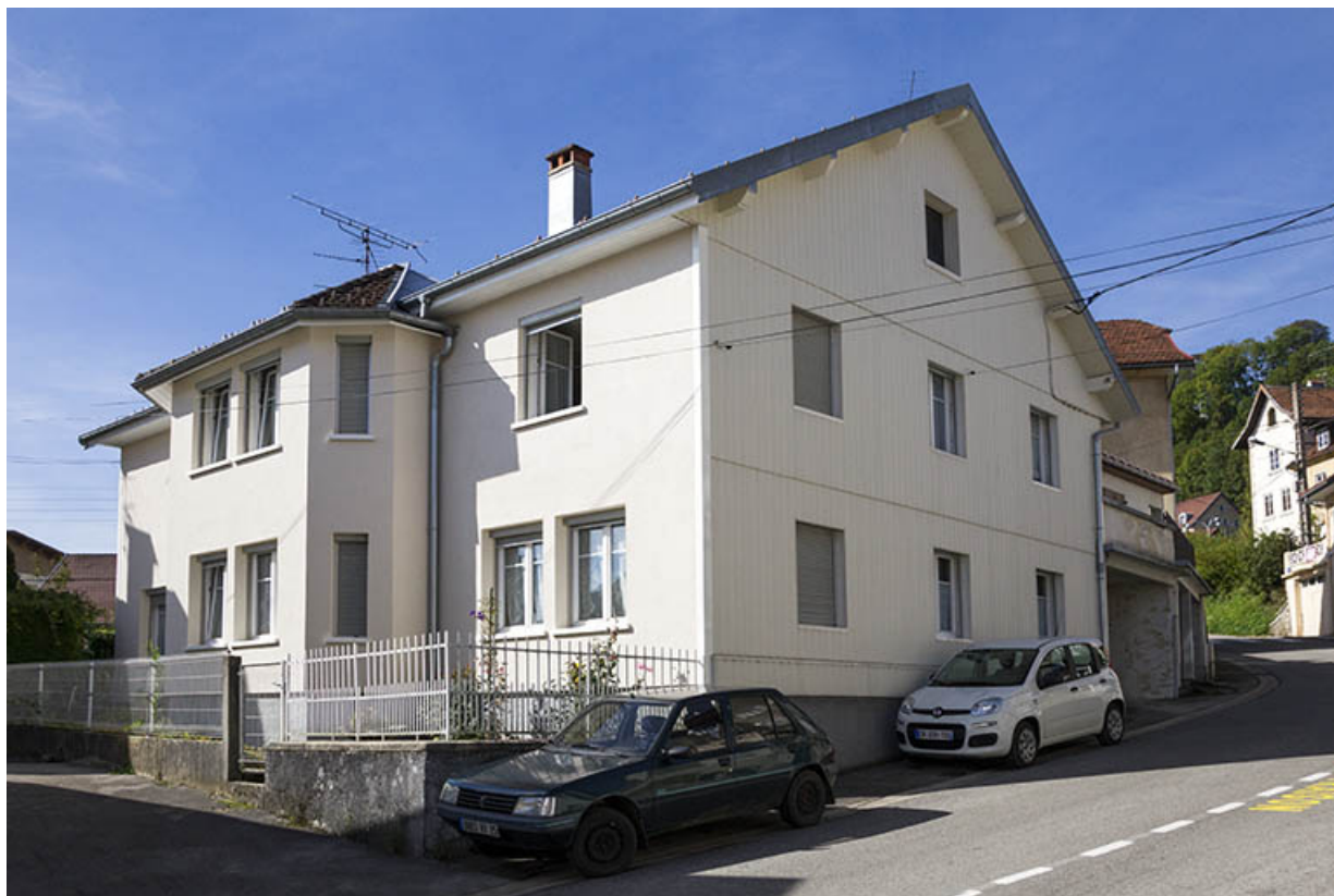
Façades antérieure et latérale gauche.
