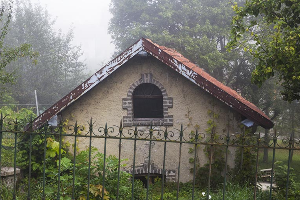
Bûcher : pignon sud.
