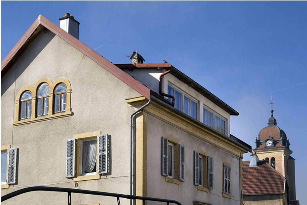
Étage et étage en surcroît (côté est).
