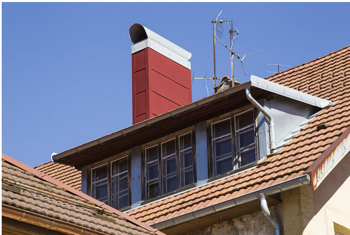
Lucarne sur le versant sud-ouest.
