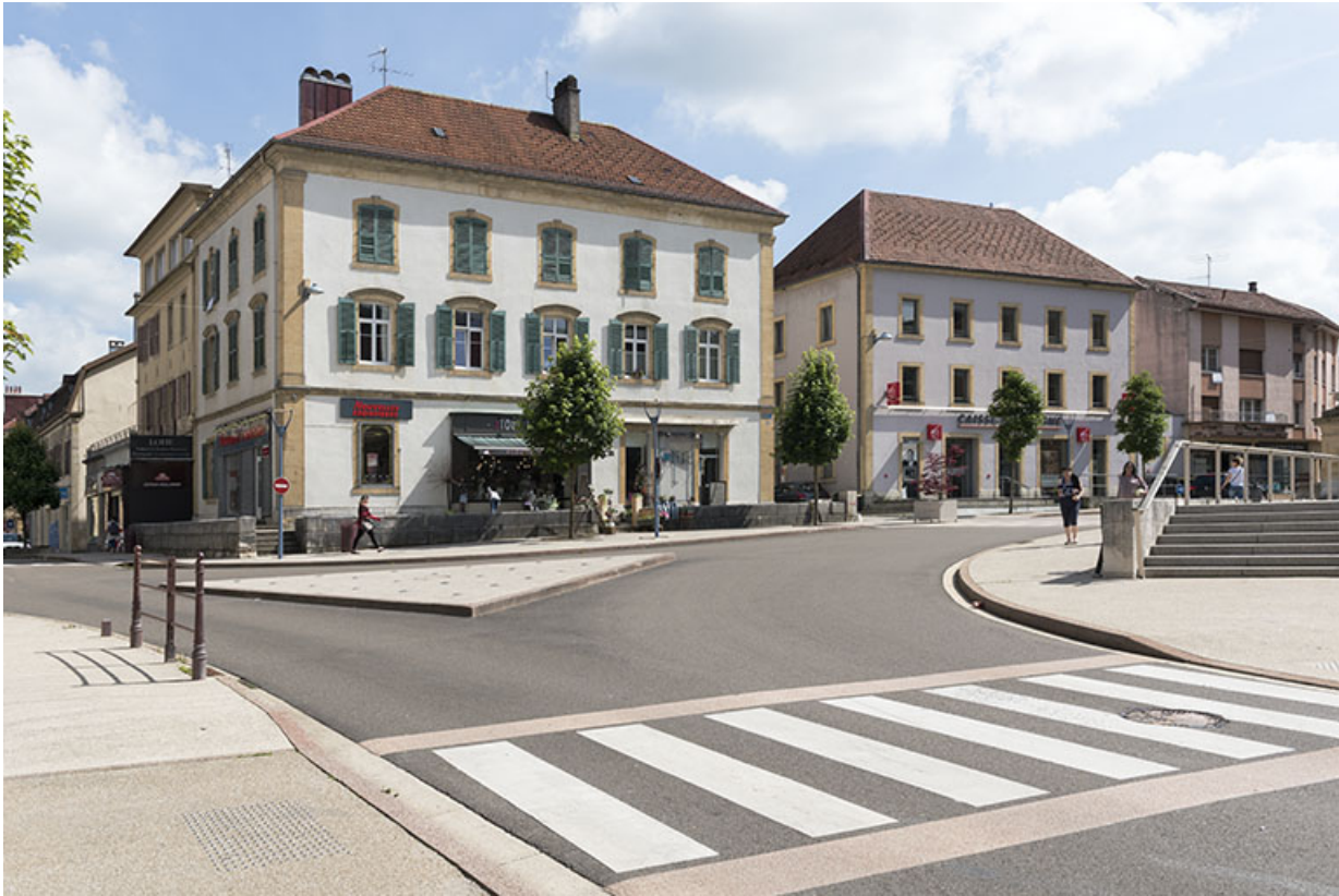
Vue d'ensemble, depuis le nord. 25, Morteau
