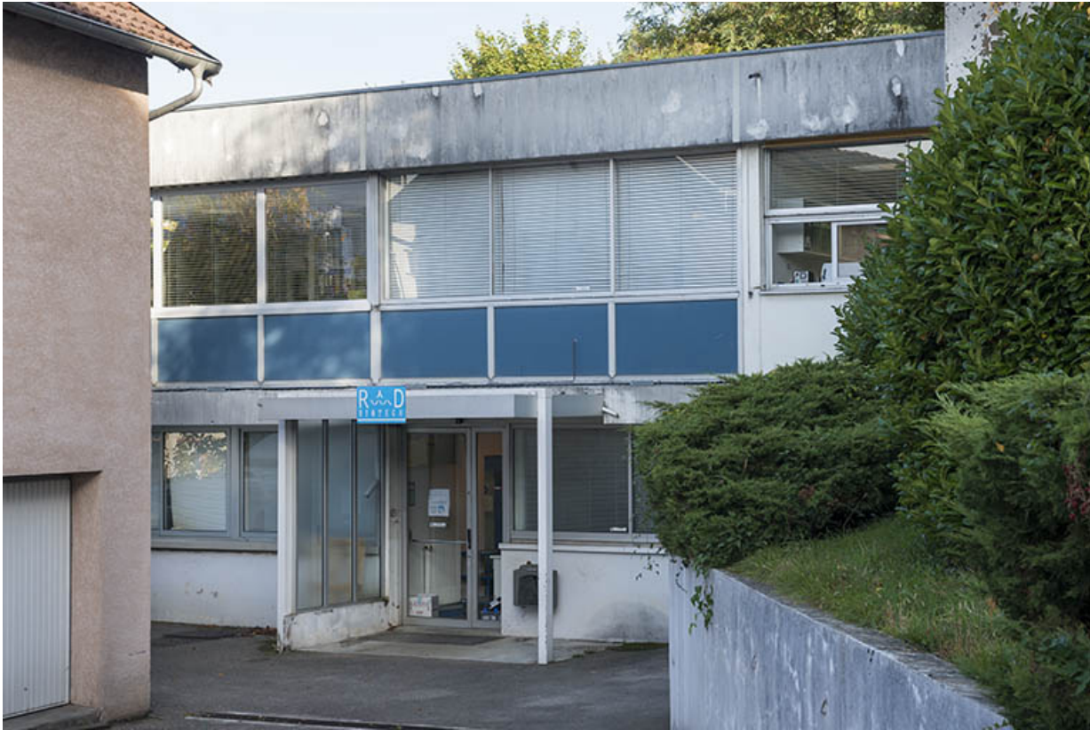
Façade sud de l'extension.
