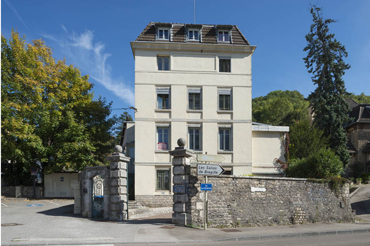
Façade ouest de l'atelier de fabrication.
