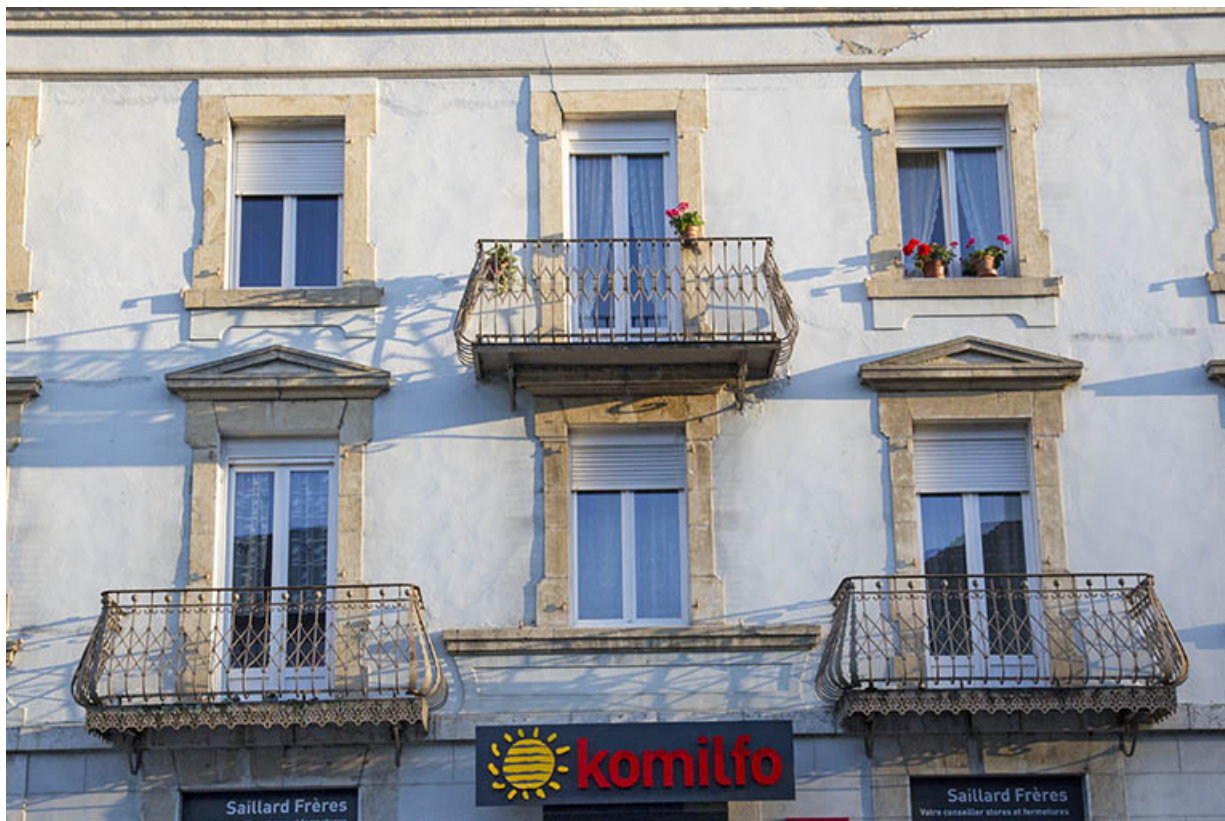
Immeuble au n° 11 : travées centrales.
