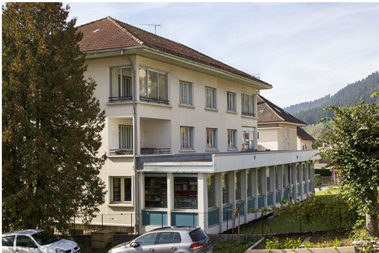
Façade postérieure, vue en enfilade.
