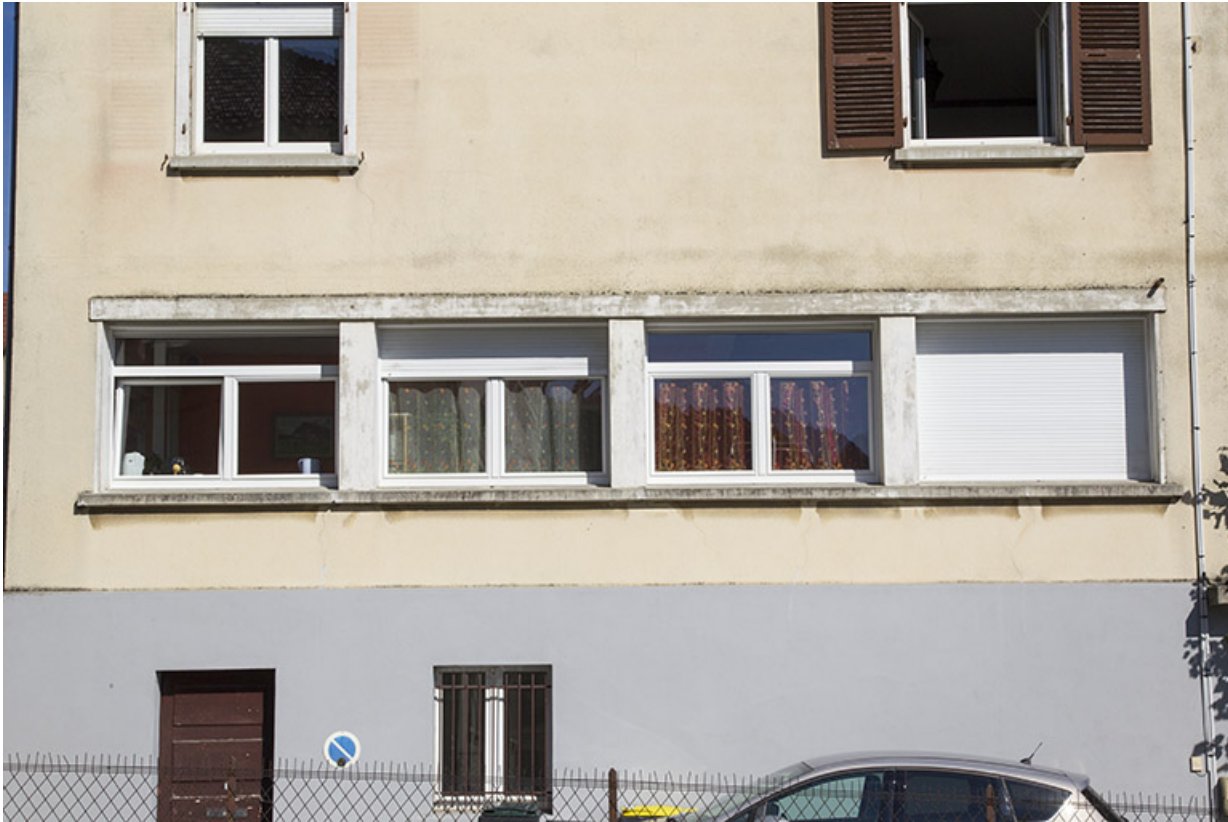
Façade latérale gauche : fenêtres d'atelier.
