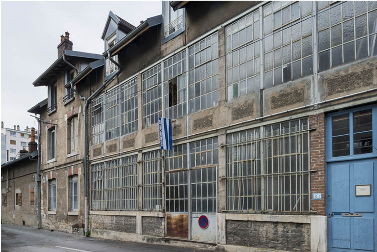
Façades d'ateliers ruelle de la Mouillère.
