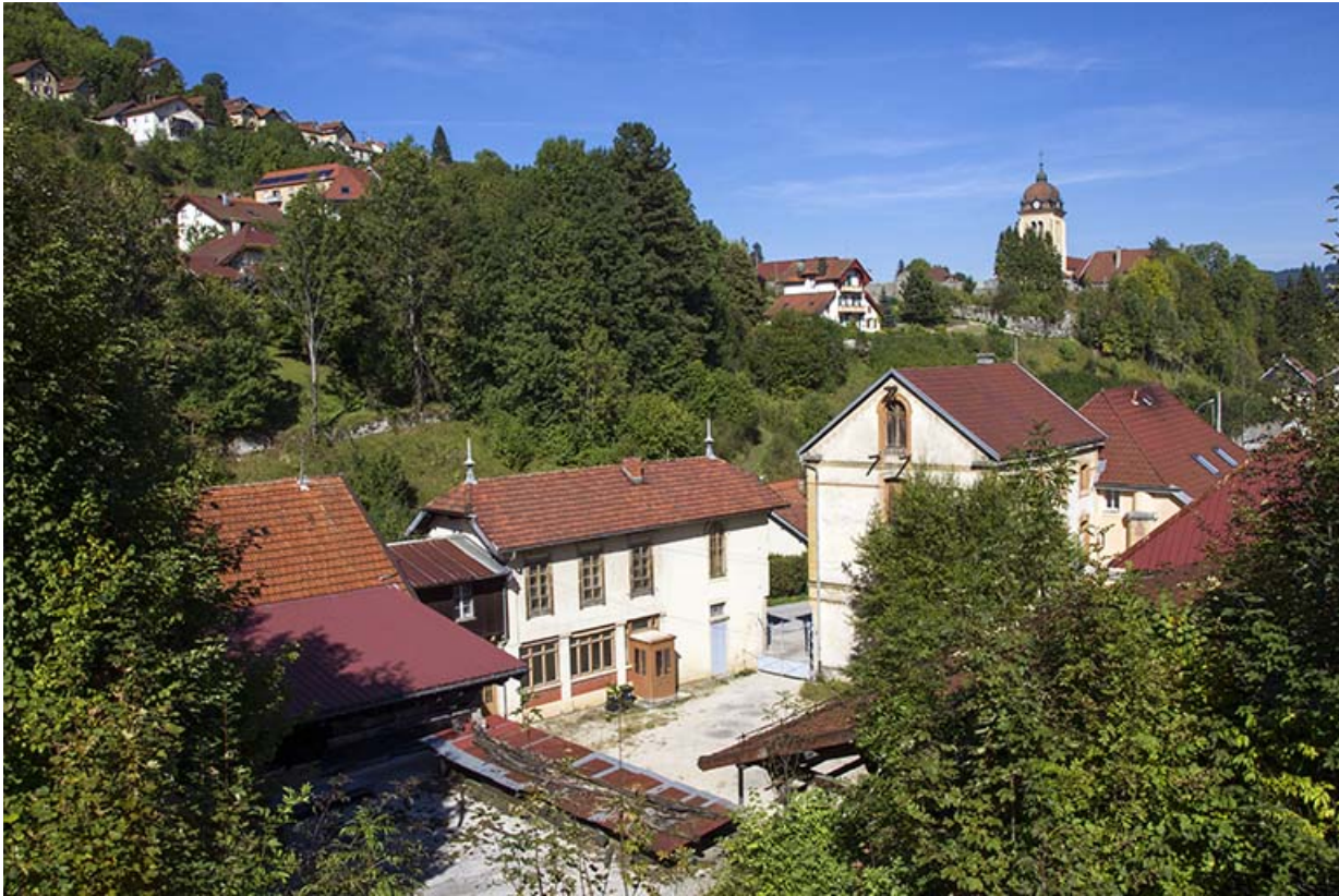
Vue d'ensemble plongeante, depuis le sud.
