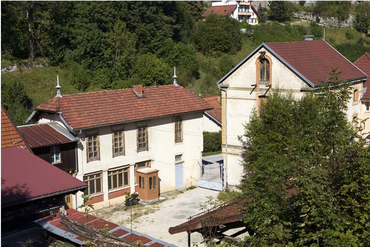
Bureau et laboratoire : façade sur cour.
