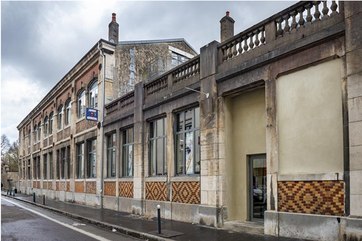
Vue rapprochée depuis le sud-ouest (après travaux).
