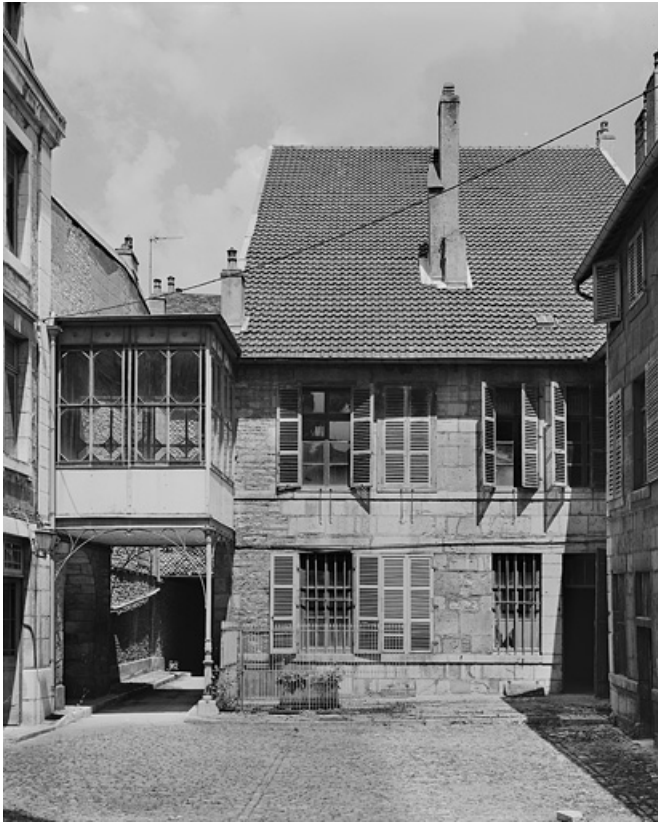
Logis sur rue : façade postérieure.
