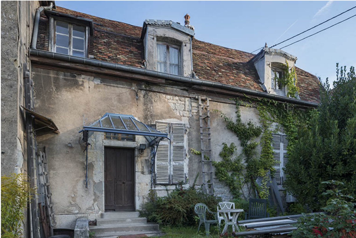
Façade sud de la maison.
