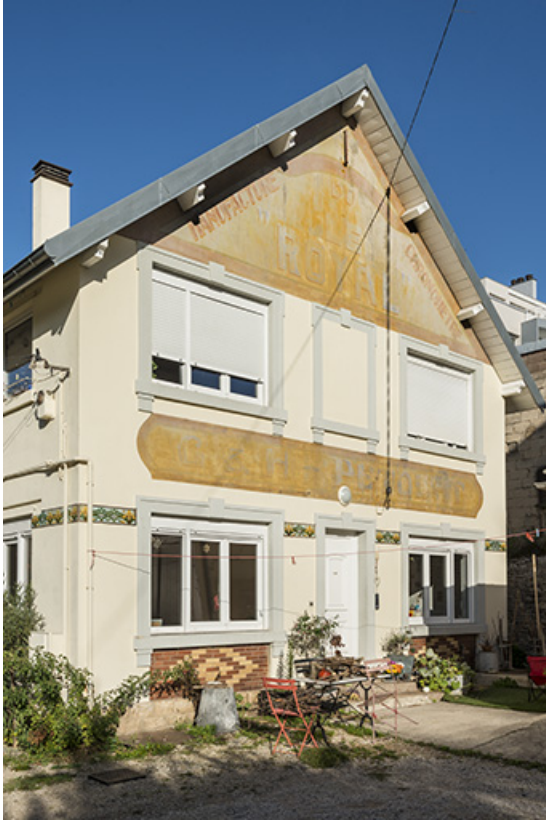
Pignon est de l'atelier.
