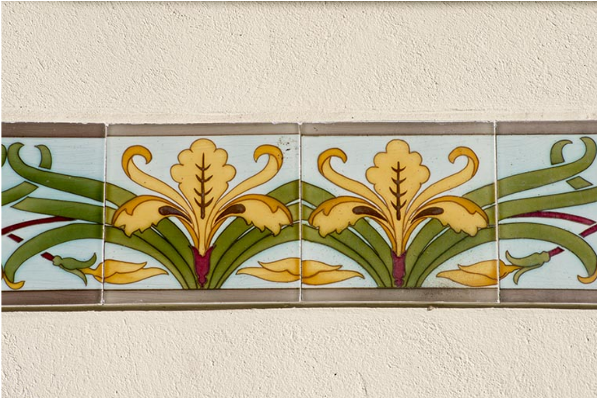
Pignon est de l'atelier. Détail des faïences.
