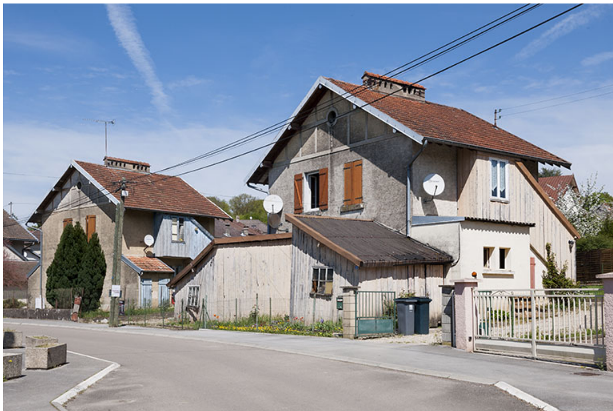
Maisons jumelées rue des Salines.
