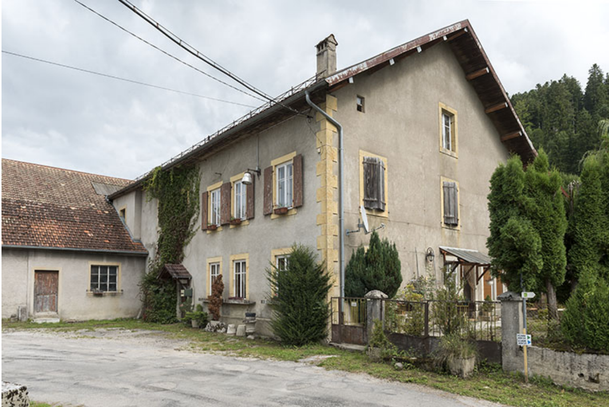
Bâtiment ancien : façades antérieure et latérale droite.
