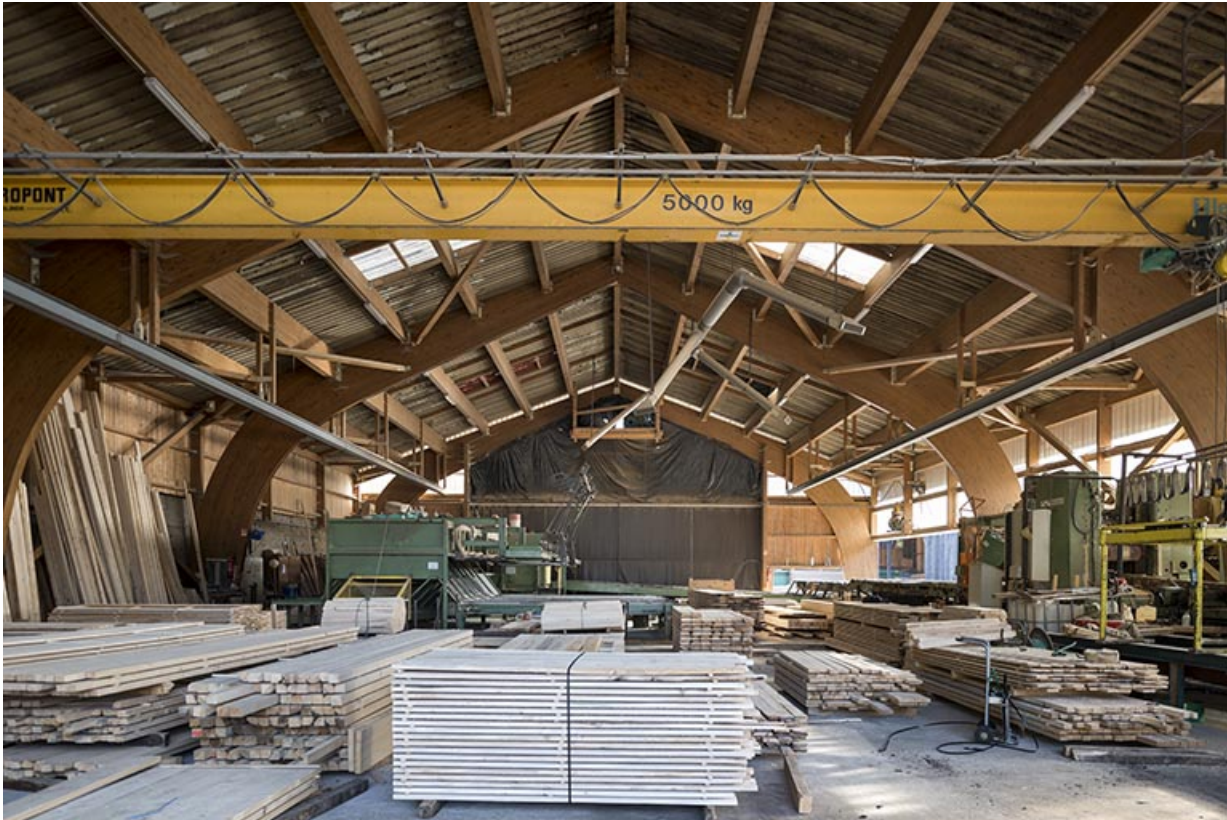
Atelier de fabrication (2000) : intérieur.
