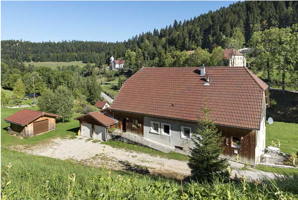
Vue plongeante sur la façade sud.
