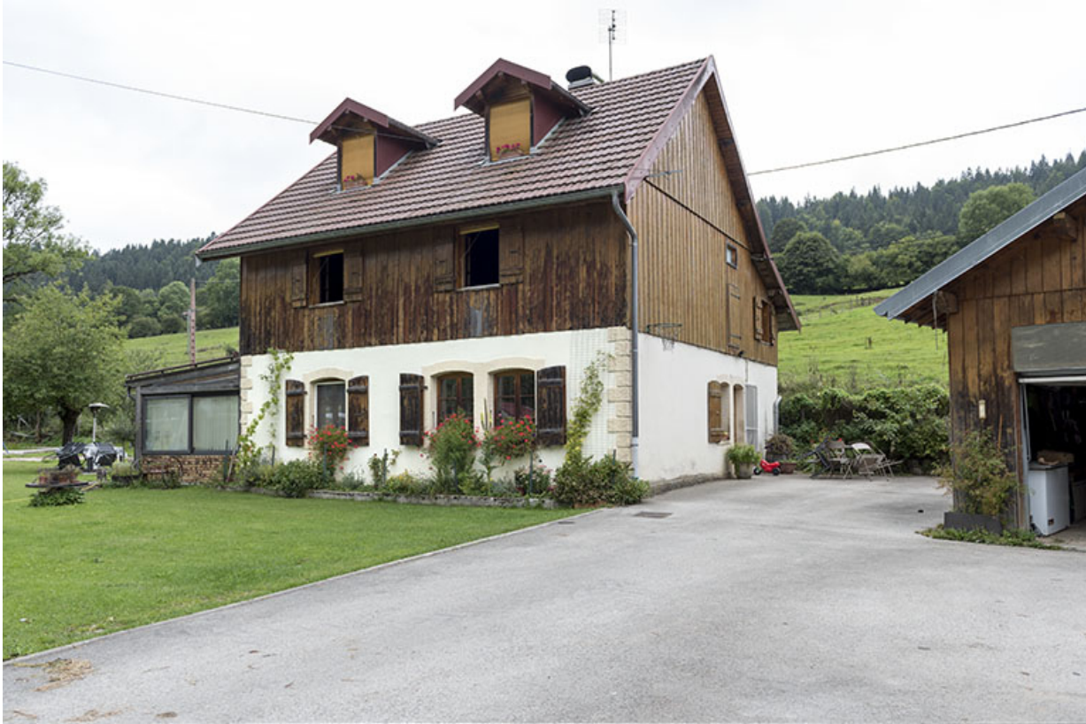
Façades antérieure et latérale droite.
