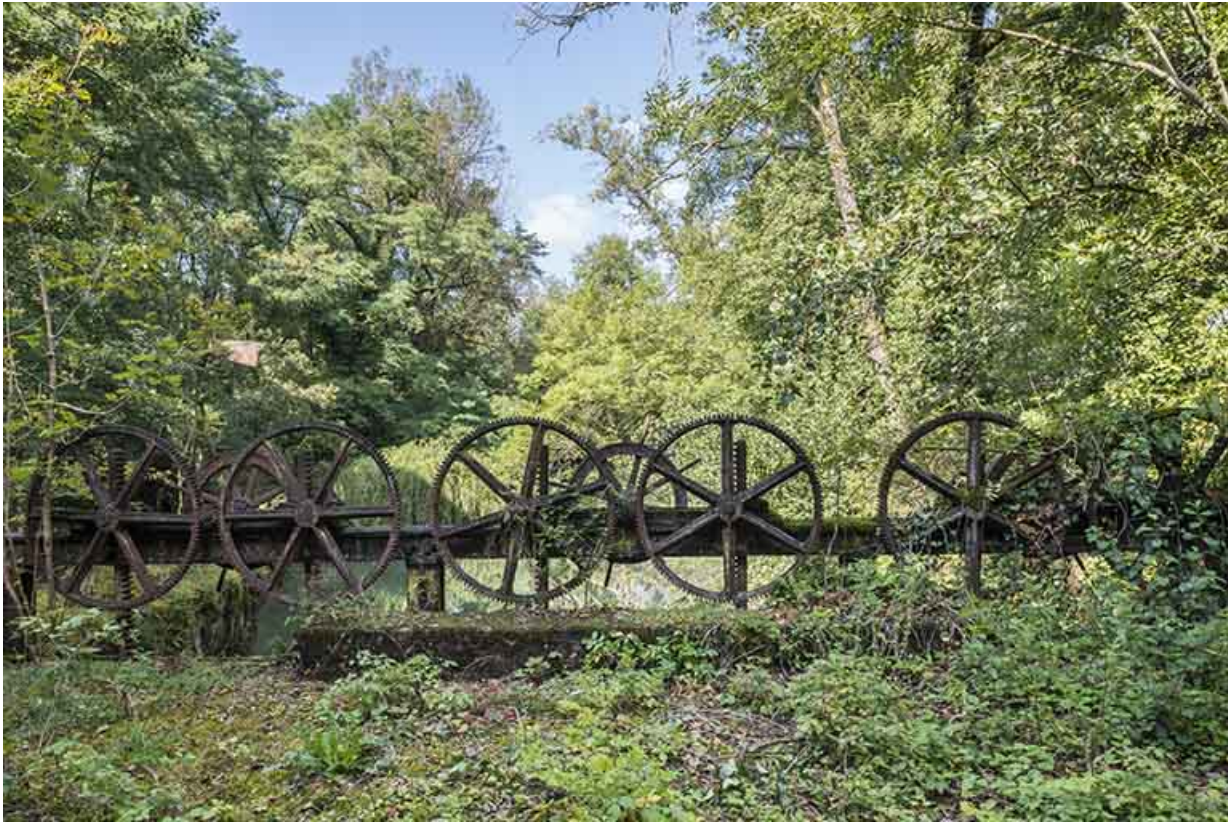
Mécanisme de levage du vannage (canal d'amenée).
