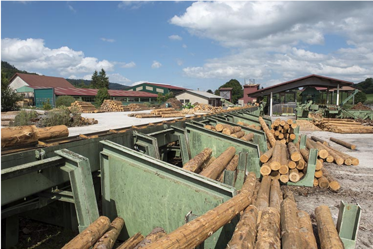
Scierie Boillot : vue partielle des installations.
