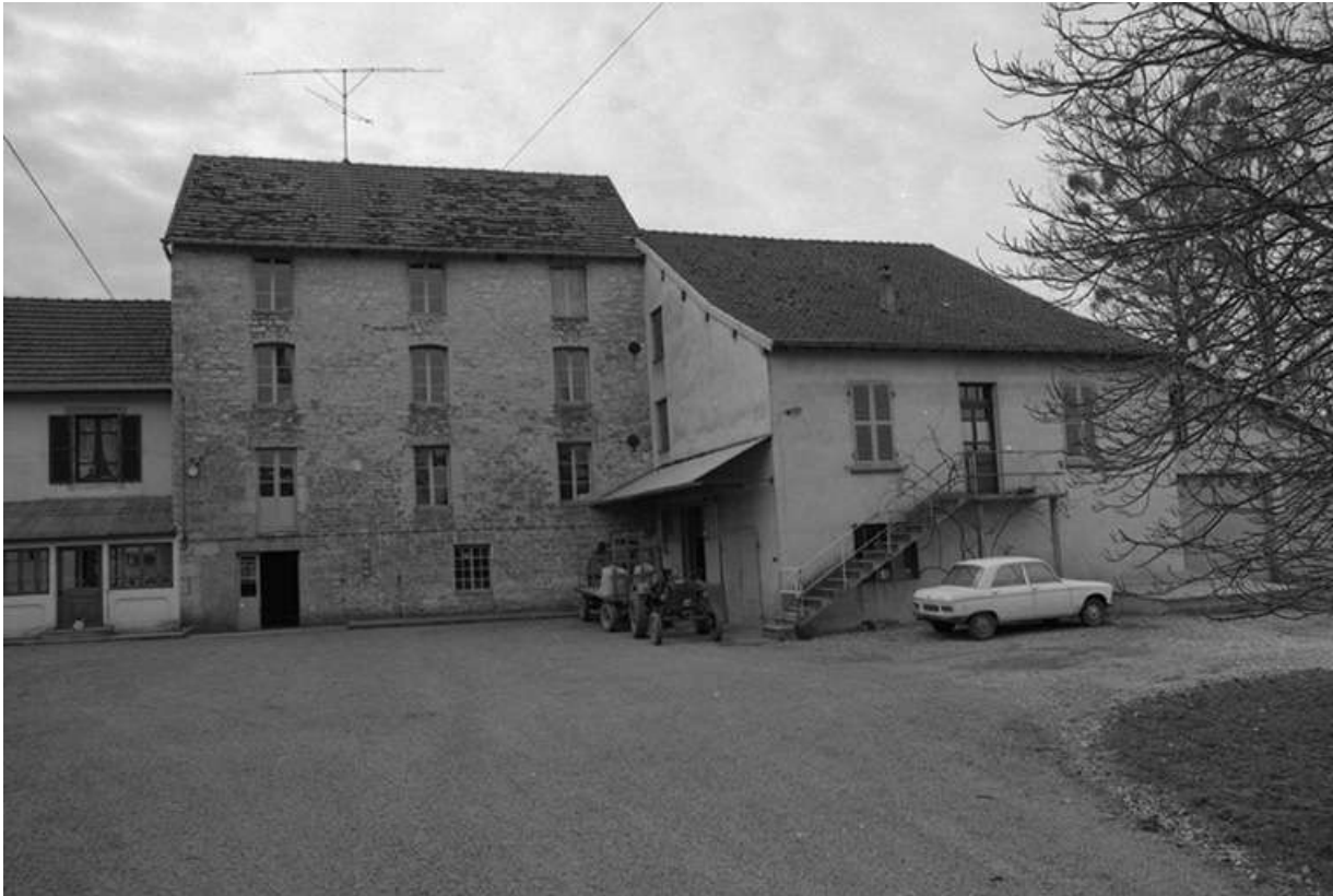
Façade nord du bâtiment.
