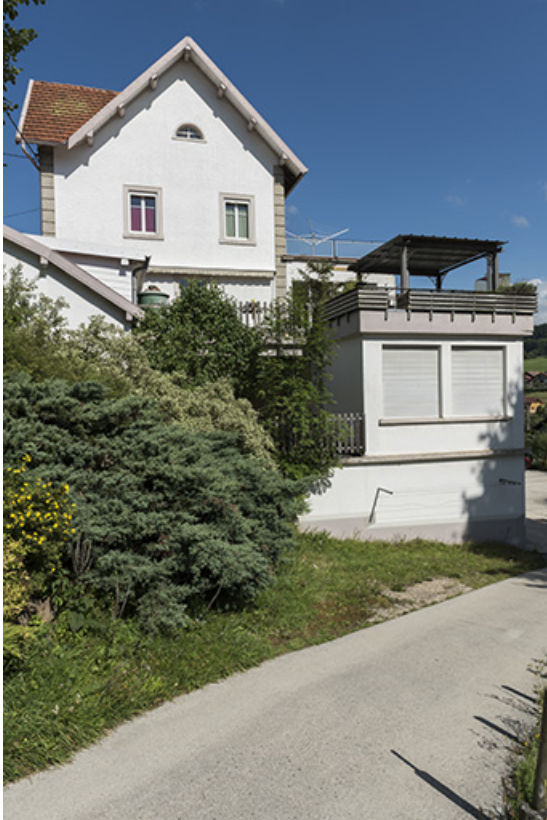
Usine : façade latérale droite.
