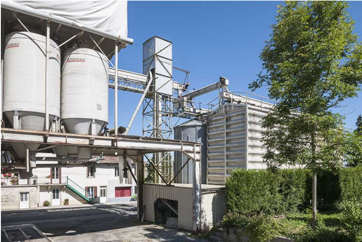
Silos et installations de chargement/déchargement.
