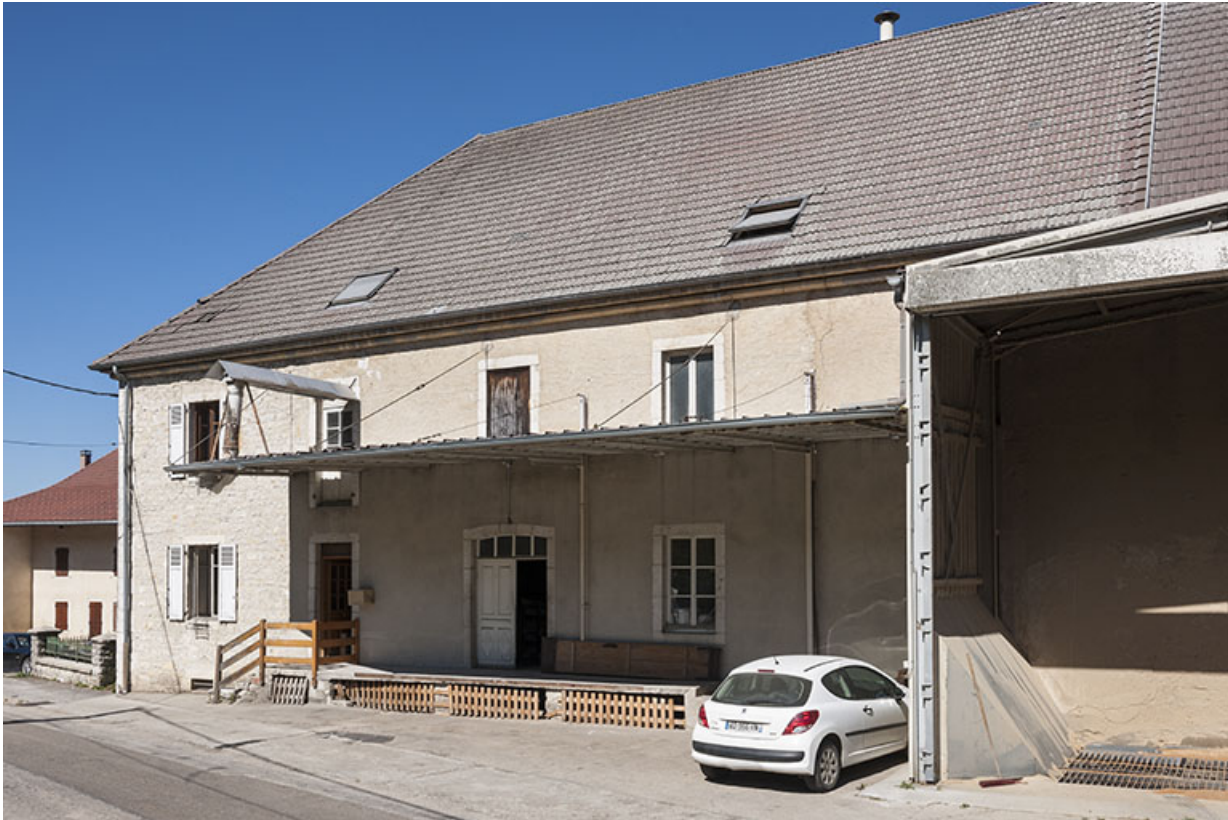
Façade sud-est de la minoterie.
