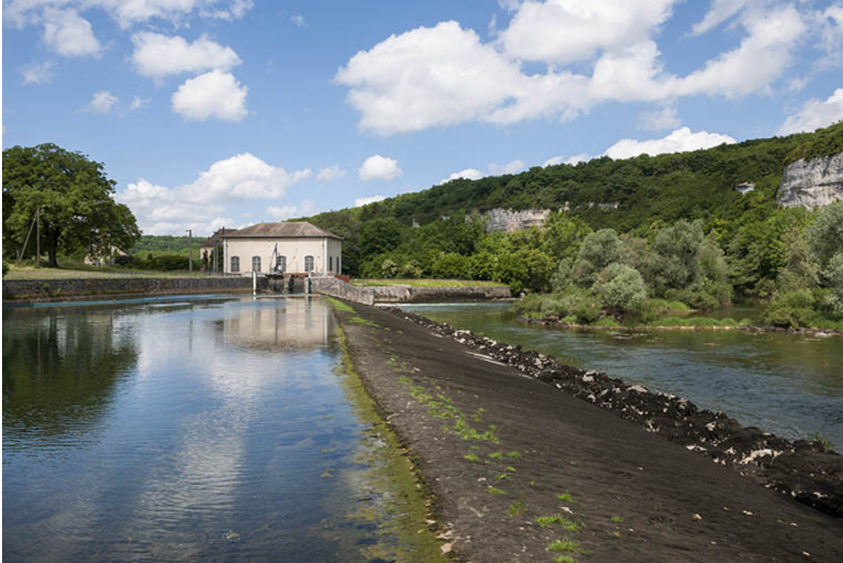
Le barrage de la centrale hydroélectrique.
