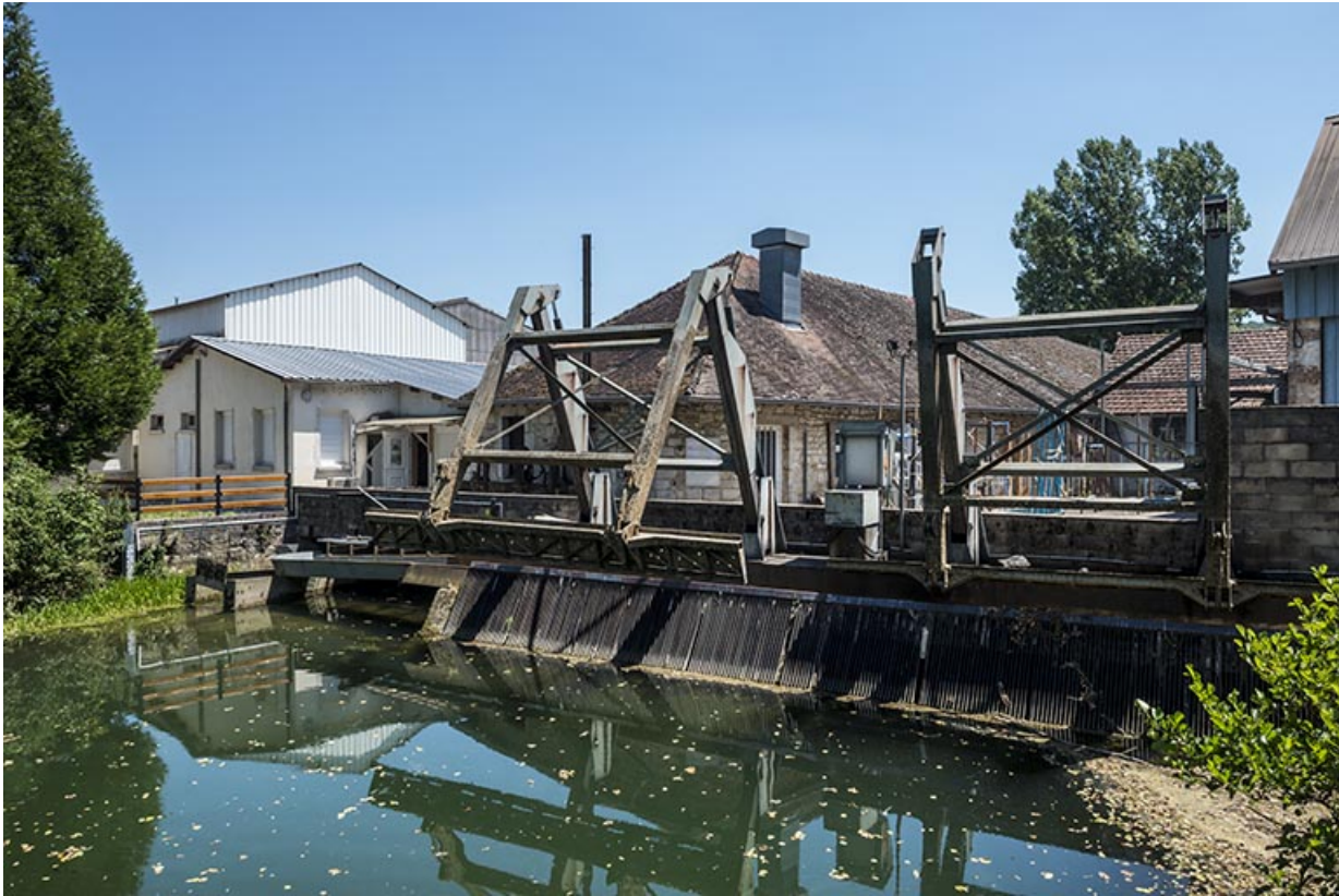
Canal d'amenée et dégrilleur de la centrale hydroélectrique.
